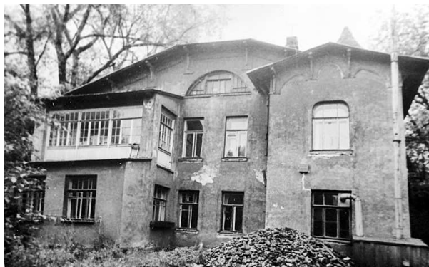
Дом № 14 на Ольгиной улице, первый этаж которого ремонтируют для размещения детского сада, 1946 г. Фото из семейного архива М. В. Скржинской
