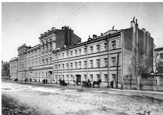
Здание Бестужевских курсов на 10-й линии Васильевского Острова. Петроград, начало XX в.
